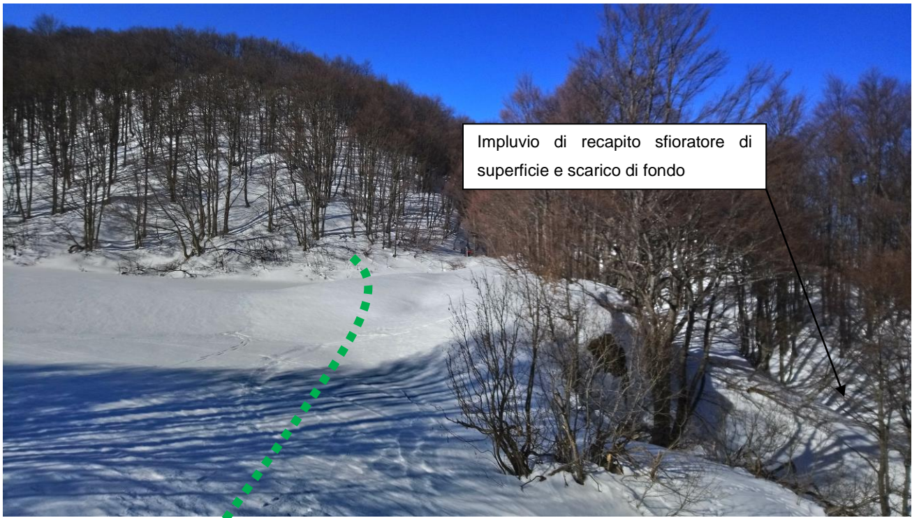
Figura 16 Vista del punto di inserimento dello sbarramento
